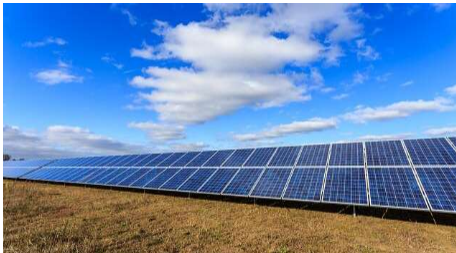
18 pav. Saulės elektrinių statyba
