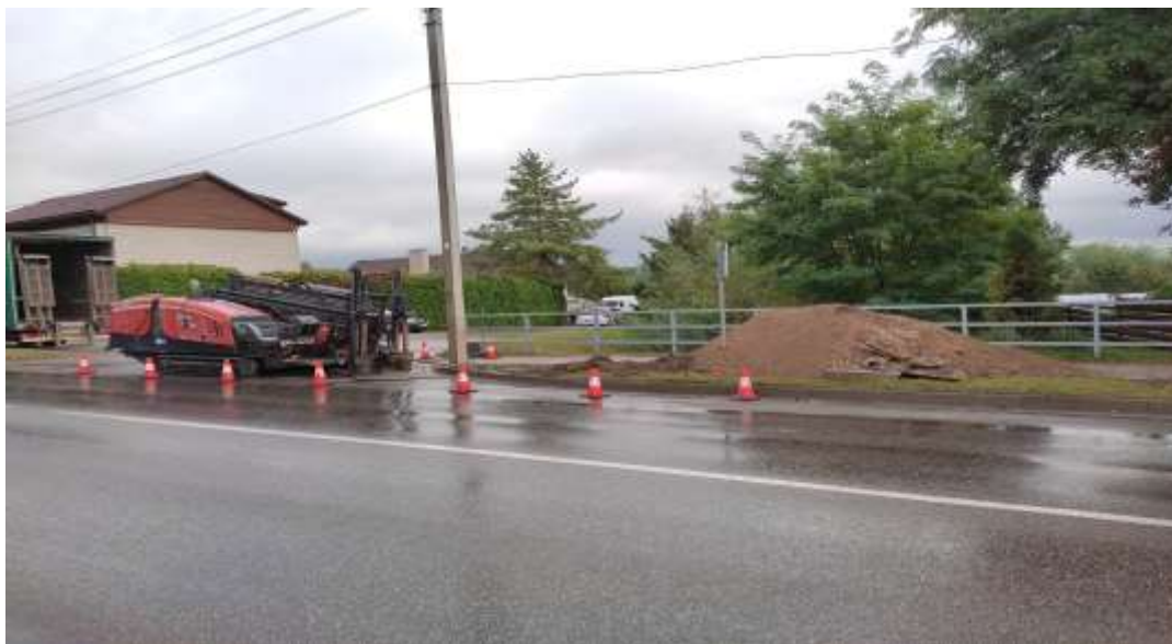
14 pav. vykdomi darbai Kauno gatvėje.
